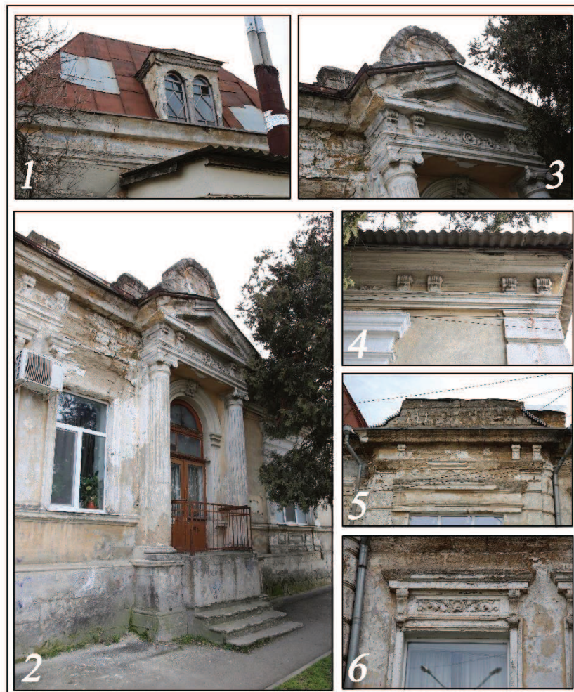
Рис. 6. Архитектурные детали оформления фасада дома В. М. Макурина: 1. Слуховое окно крыши беседки; 2. Портал главного входа; 3. Карниз и фронтоны портала главного входа; 4. Карниз западной пристройки; 5. Детали карниза эркера; 6. Детали оконного декора. Фотоснимки Д. А. Ломакина, 2025 г.
