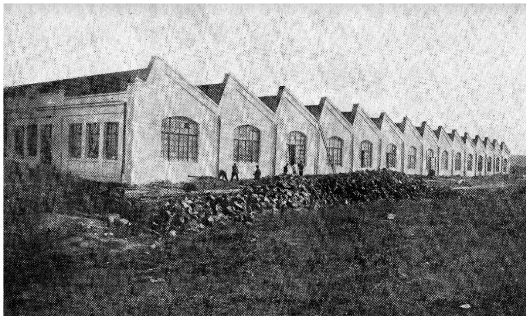
Фабрика «Красный луч» – отделка фасада южной стороны (иллюстрация к статье: Абдулжанов Г. Новая обувная фабрика в Крыму // Экономика и культура Крыма. – 1935. – № 1. – С. 36-44).
