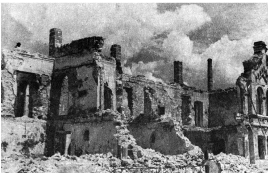
Рис 3. Симферополь. Разрушенное в годы Великой Отечественной войны здание бывшего Архиерейского подворья. В 1955 г. на этом месте построена гостиница «Украина» (в настоящее время – ул. А. Невского, 7). Фото 1945 г.
