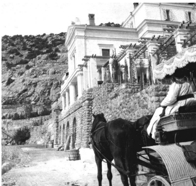
Рис. 26. Балаклава. Дом графини Апраксиной на западной стороне бухты (главный корпус имения «Прибой»)
