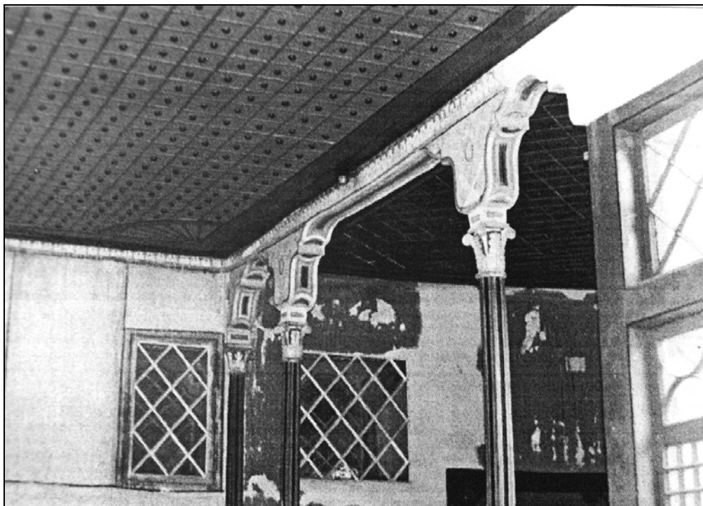
Рис. 1. Общий вид конструкций перекрытия Посольского зала
